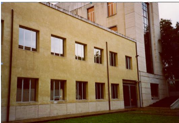
Ampliamento (1993) di scuola a Forlì
